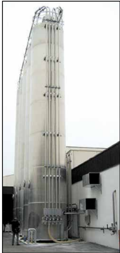
Un impianto alimentare a Budrio
