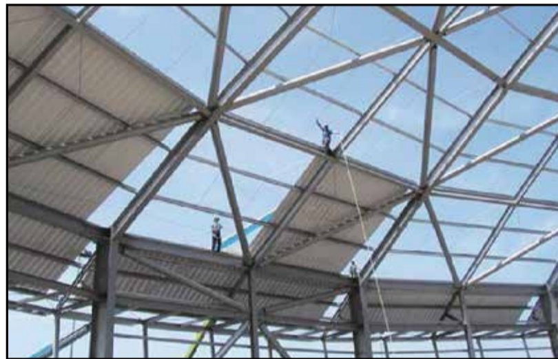
Una costruzione metallica con relativa copertura sita in Albania
