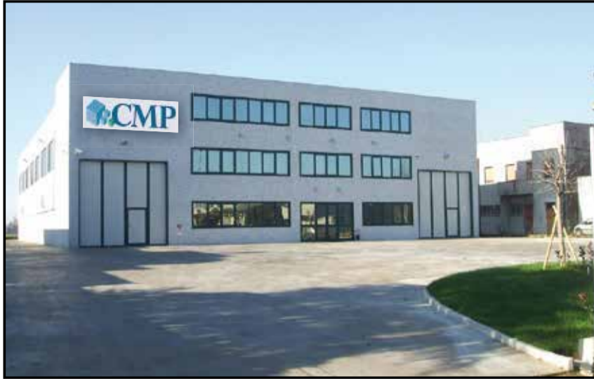
La sede di Bondeno (Fe). Nelle immagini a fianco alcuni dei principali lavori realizzati dalla CMP
