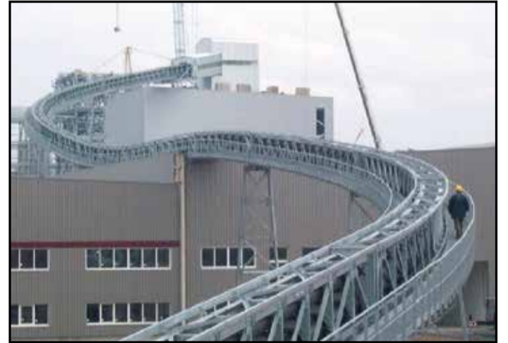
Un impianto per il trasporto legno per pannelli truciolari
