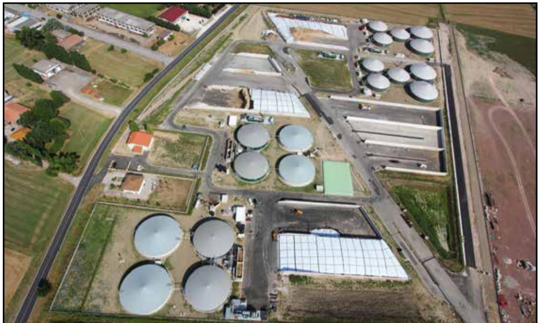
L'impianto visto dall'alto
