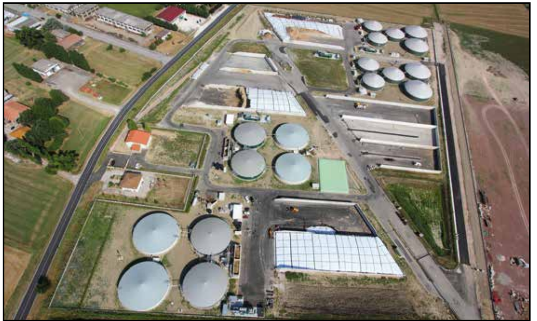
L'impianto visto dall'alto
