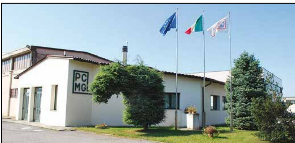
Vista dell'esterno della sede
